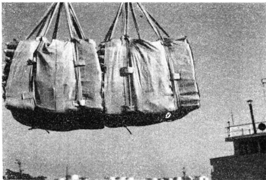
モッコ荷役作業テスト (静岡県・田子ノ浦港)
